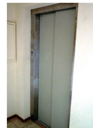
Bild 3: Verkleideter Drehtürrahmen mit Teleskoptür
